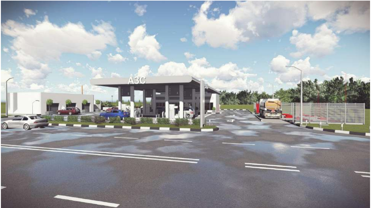
Подсветка островка и зоны въезда\выезда на АЗС
